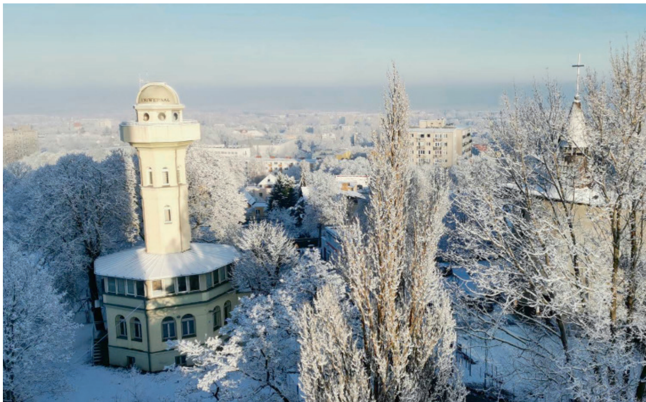
Wieża Braniborska, widok współczesny
